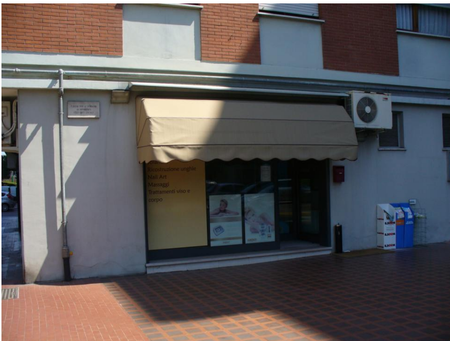
42. Centro di estetica, condominio Andromeda – vista da via Longhena
