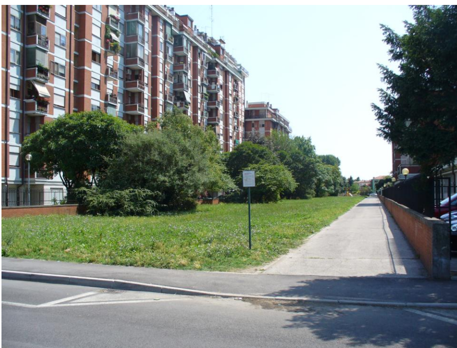
15. Stradone, a dx Condominio Stella – vista da Via Palladio
