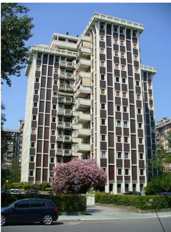
21. Torre 25 – vista da via Massari
